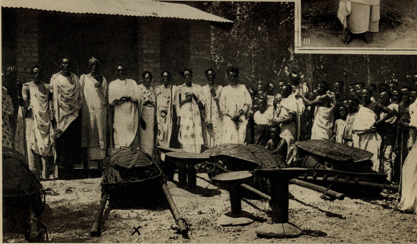
Le roi Musinga, qui régnait, depuis 1897, sur le Ruanda, appartient à la vieille race des Sultans qui, tout en paraissant se rallier au nouvel ordre des choses, menait une opposition sournoise à toute mesure de progrès et de civilisation. Il a été déposé le 12 novembre et exilé dans le Kivu. Son fils aîné Rudahigwa, qui lui succède sous le nom de Mutara, a pris solennellement possession du trône le 16 novembre. La photo I montre la cérémonie de la proclamation, sur la tribune royale. De gauche à droite: le résident, M. Coubeau, le nouveau roi Mutara, le gouverneur M. Voisin. Photo II. De gauche à droite: M. Coubeau, résident, le roi Mutara, le major Duvivier, M. Stevens, administrateur. Photo III. Le roi Mutara Rudahigwa, qui est catéchumène. Photo IV. Les tambours royaux, emblèmes de la souveraineté, sont remis au nouveau roi; aux pieds de Mutara, le kalinga, marqué par une croix, le tambour royal par excellence.
