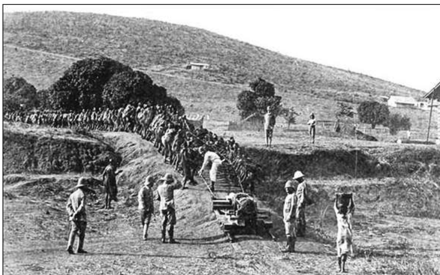
LA CONSTRUCTION D'UNE FORTIFICATION ALLEMANDE
