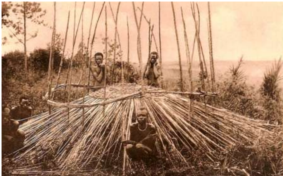
LA CONSTRUCTION D'UNE MAISON
